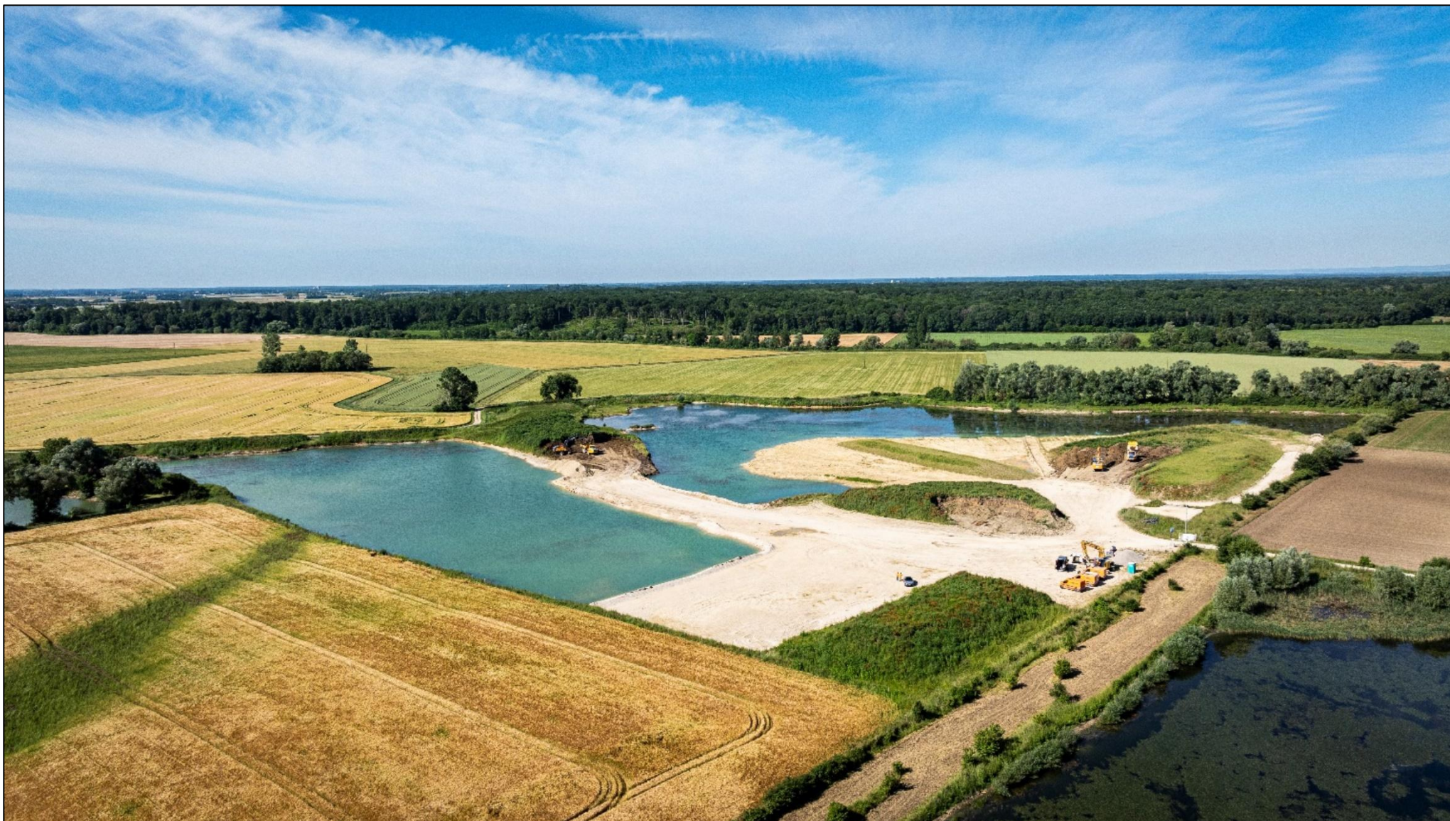
Photographie 1 : Vue aérienne en direction du Sud-Ouest
