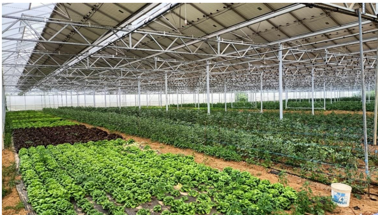
Figure 7: Serre réalisée par Technique Solaire (Serres de la Guittière, 79800 Pamproux)
