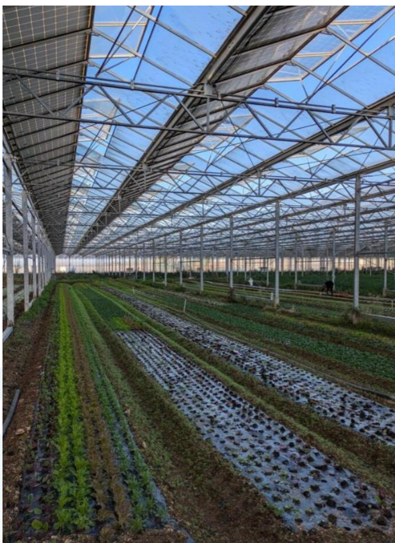
Figure 8: Serre photovoltaïque de la S.A.R.L DEVERS réalisée par Technique Solaire
