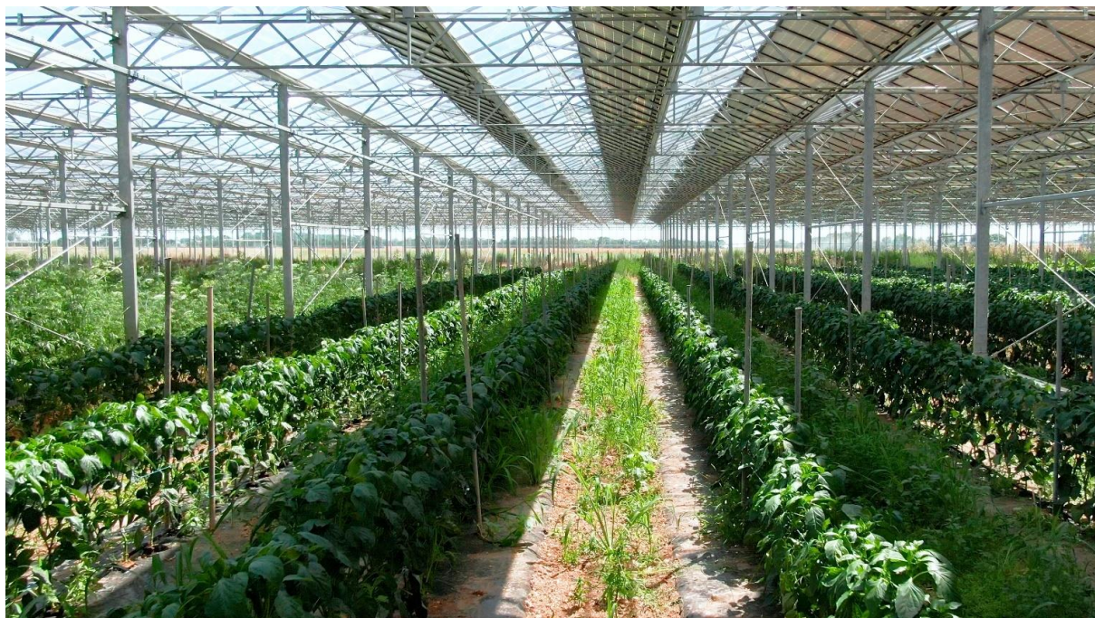
Figure 1: Serre photovoltaïque réalisée par Technique Solaire. Source: Technique Solaire
