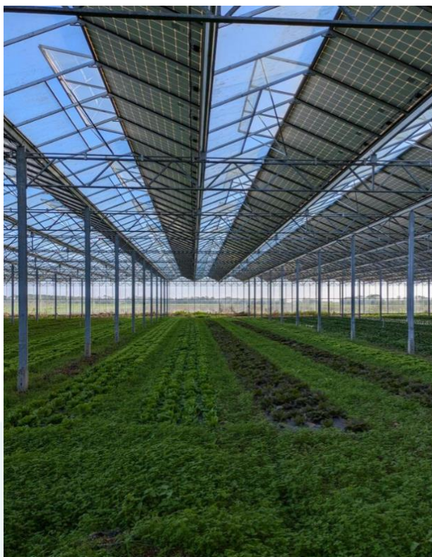
Figure 2: Serre photovoltaïque de la S.A.R.L DEVERS réalisée par Technique Solaire
