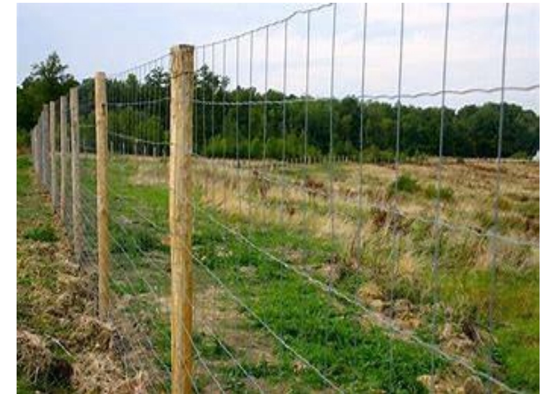
Photo 4 : Exemple de portail et clôture en acier galvanisée et poteaux bois (Source : Paysage ...photovoltaïque, DREAL Grand Est 2024)
