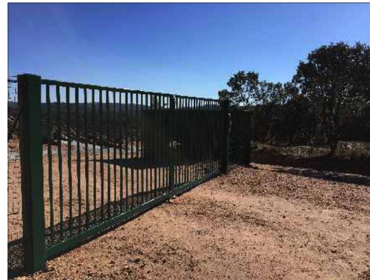
Photo 4 : Exemple de portail et clôture en acier galvanisée et poteaux bois (Source : Paysage ...photovoltaïque, DREAL Grand Est 2024)
