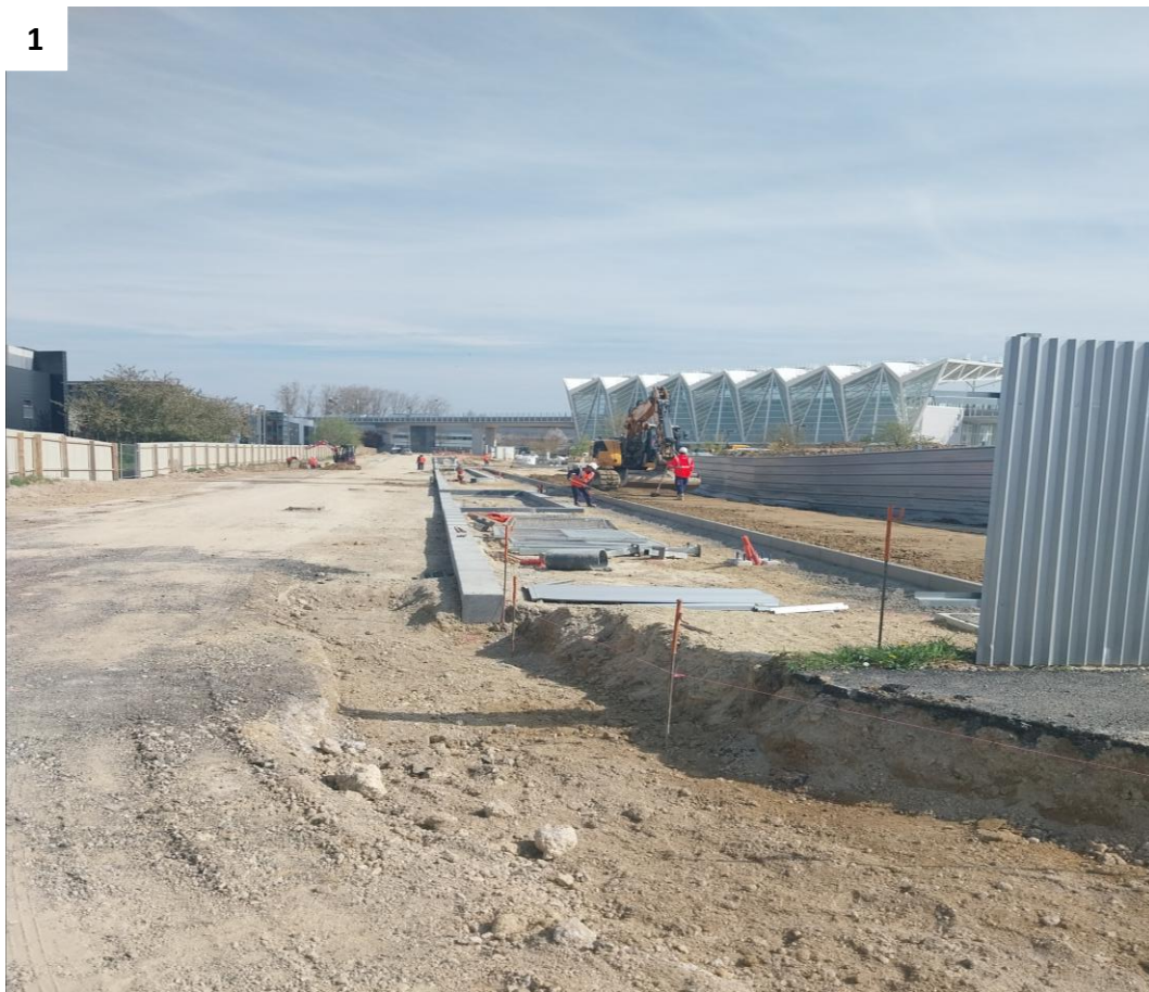
Photographie 1 : Vue depuis la rue Rosalind Franklin au nord-ouest de la parcelle en direction de l'est (24 mars 2026)
