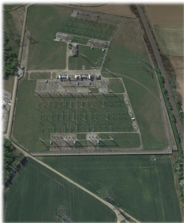
Figure 1 : vue sur le type d'installation envisagé, ici le poste 400 000 / 225 000 volts de Sierentz. Source : RTE
