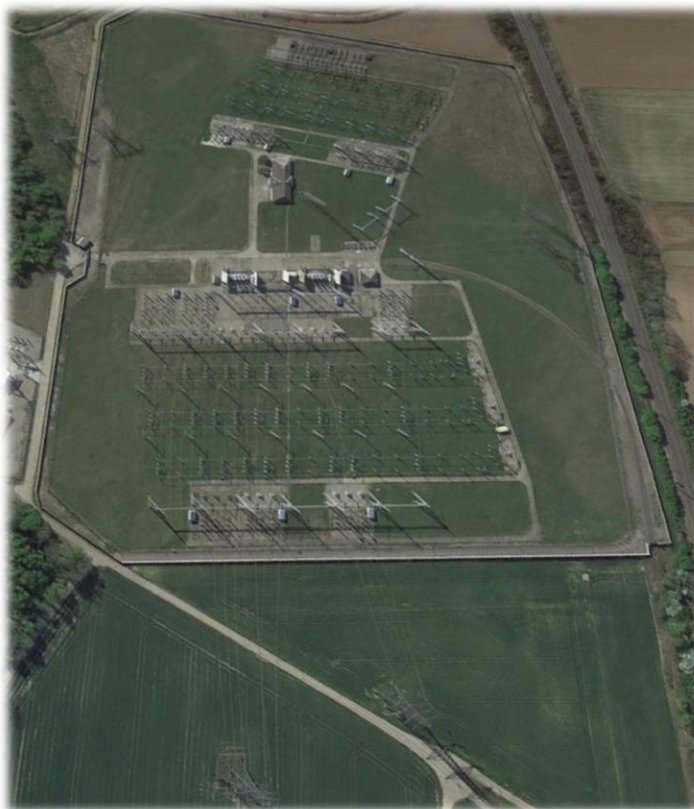
Figure 1 : vue sur le type d'installation envisagé, ici le poste 400 000 / 225 000 volts de Sierentz. Source : RTE
