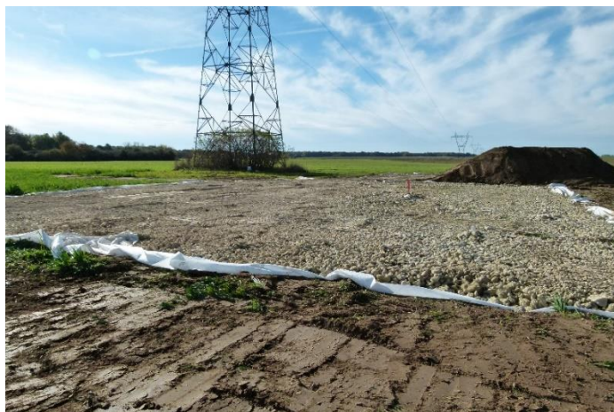
Plateforme d'assemblage et de levage
