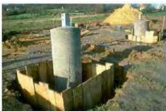
Fondations superficielles à gauche et fondations spéciales avec micropieux (à droite)
