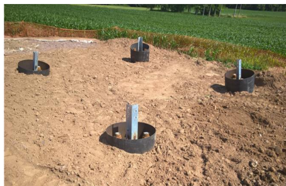
Fondations superficielles à gauche et fondations spéciales avec micropieux (à droite)
