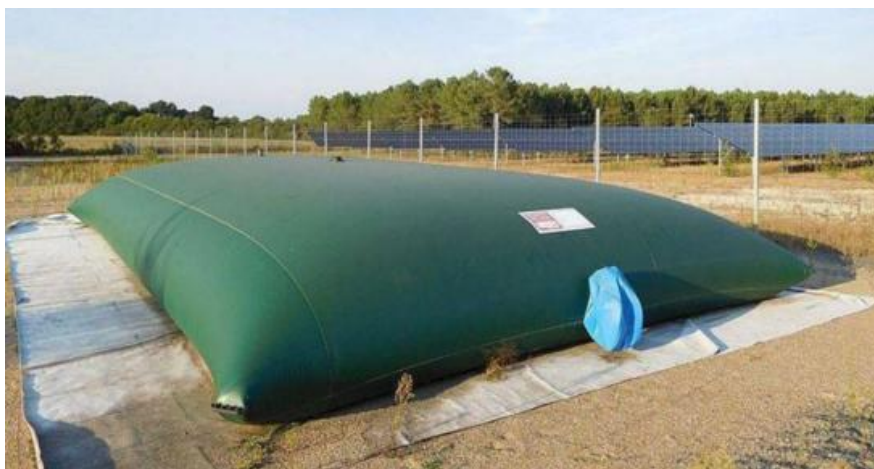
Illustration 4 : Exemple de citerne souple autoportante d'eau de défense incendie
