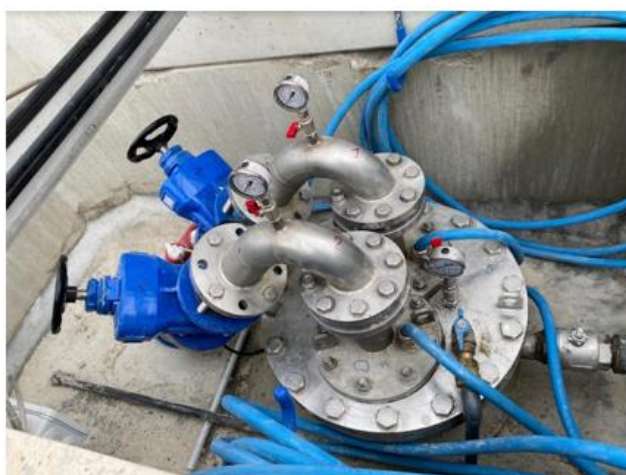
Figure 11 : Exemple de protection de tête qui sera mise en œuvre sur le forage F3 pour son exploitation
