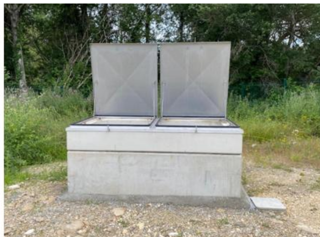
Figure 11 : Exemple de protection de tête qui sera mise en œuvre sur le forage F3 pour son exploitation
