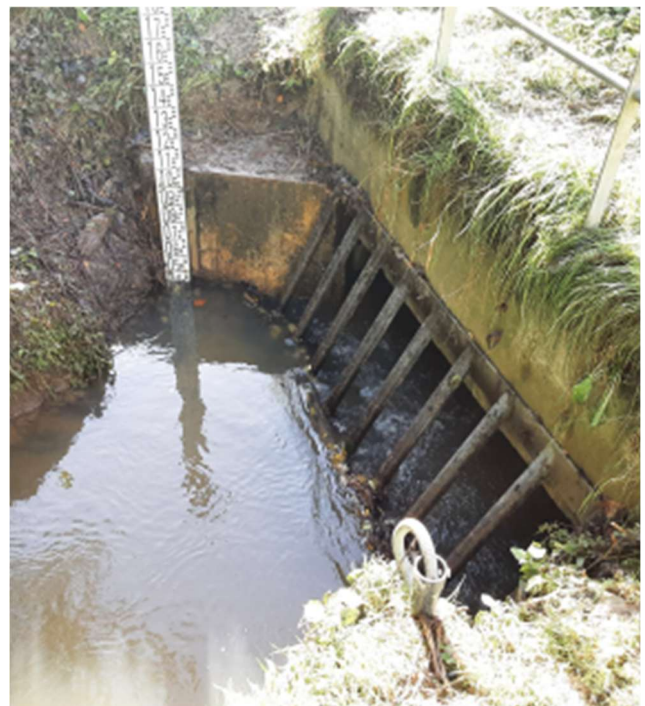
Figure 9 : Organe de régulation du débit dans le ruisseau de Berthenlaire
