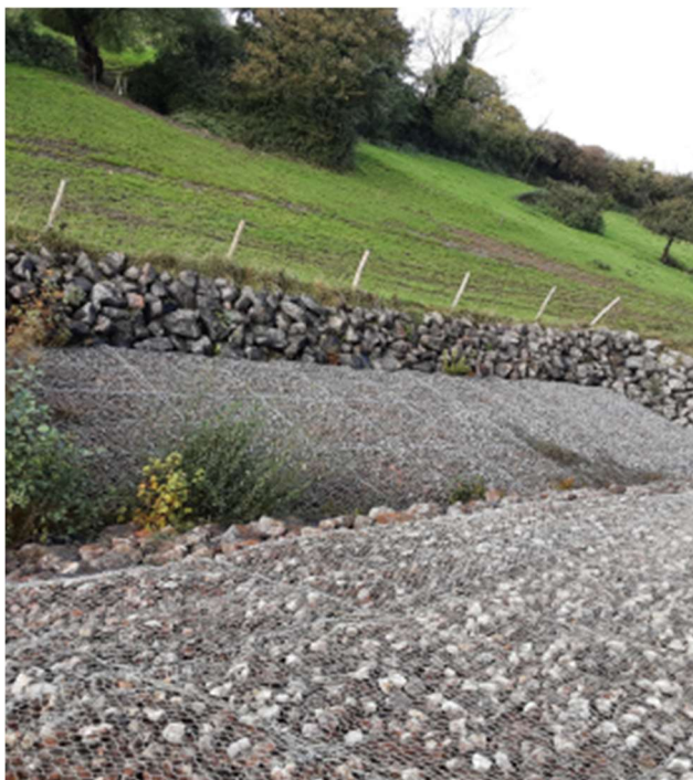
Figure 8 : Bassin de réception des eaux de surverse de la ZEC de l'Hermite
