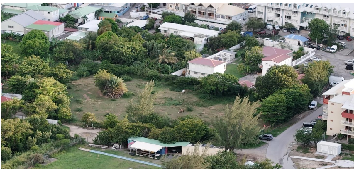
Figure 2 : Prise de vue 1 - orthophoto oblique du terrain du projet (Impact Mer, 2025) – vue du Nord
