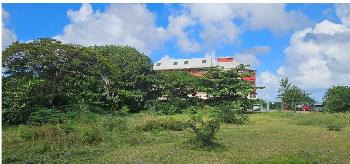
Figure 33 : Vue en direction de la résidence Le Grand Saint-Martin, mettant en évidence l'implantation du projet en frange de l'urbanisation.
