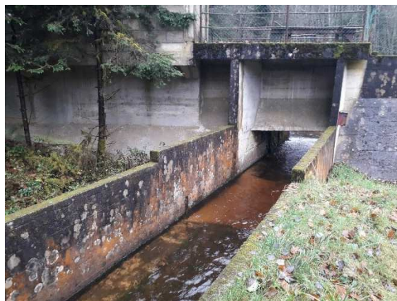
Canal de dérivation de la Besbre au niveau de la digue amont (ECTARE, nov.2023)
