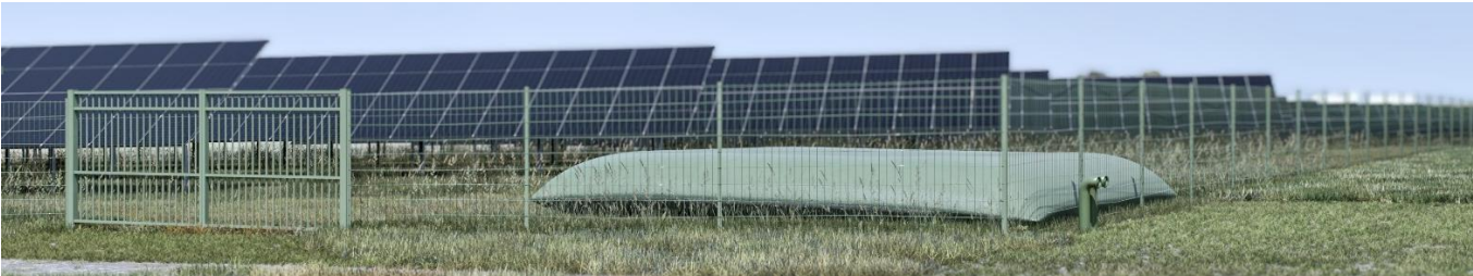
Figure 9 : Clôture et portail utilisés pour le parc solaire de Saint-Aoustrille
