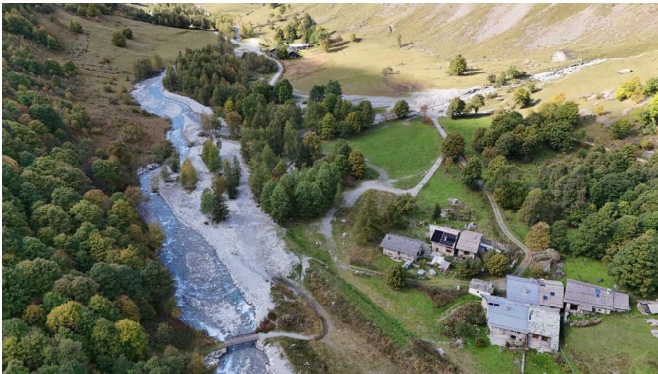
P4 : Doron de Champagne au Laisonnay du haut, vue vers l'aval, torrent du Py arrivant en rive droite, septembre 2025
