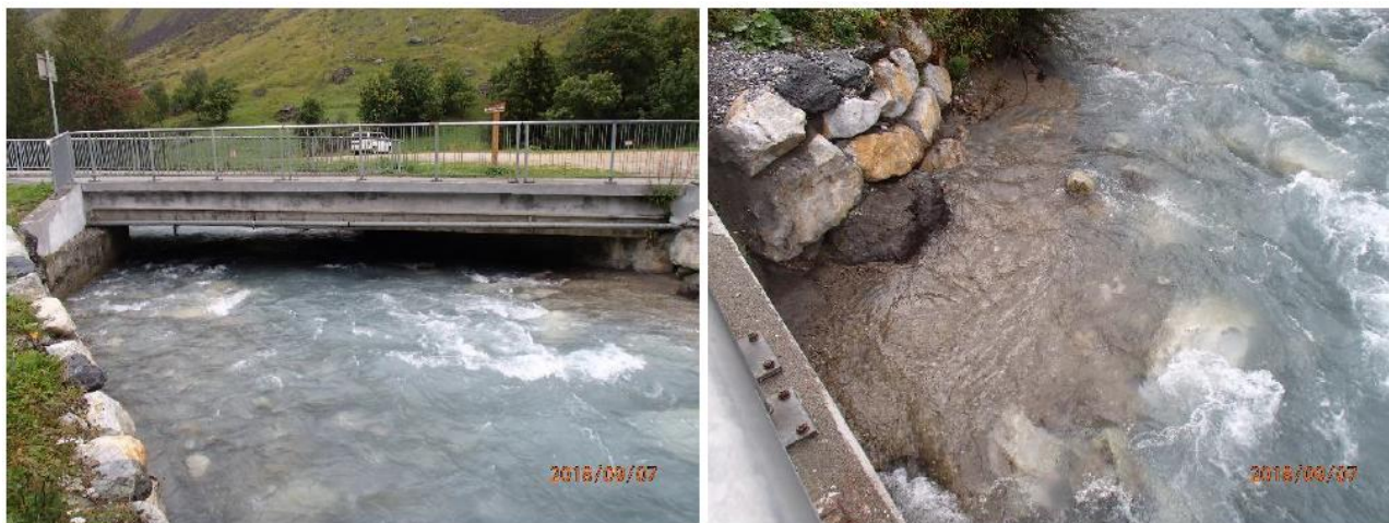
Pont de la route départementale au Laisonnay du Bas et confortement en béton de la culée (rive droite sur la photo de droite)
