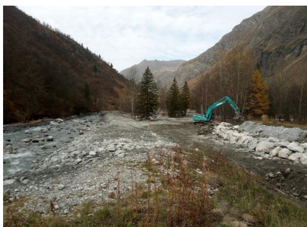
Travaux APTV post crue 2024 - Confortement en enrochement de la digue du Refuge
