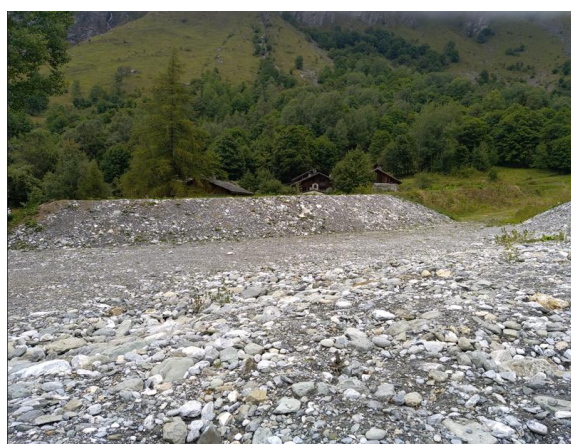
Fin de travaux post crue - Remblaiement des enrochements de la digue du Refuge par les matériaux du site
