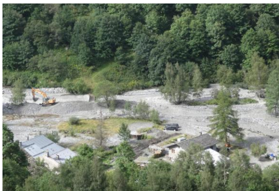
Travaux post crue en 2015 – Laisonnay du haut
