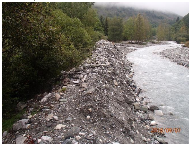
Merlons de curage en aval de la confluence avec le torrent du Py
