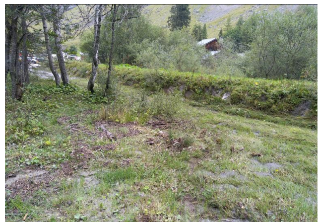
Merlon avec parement en enrochement captant les remontées de la nappe du Doron
