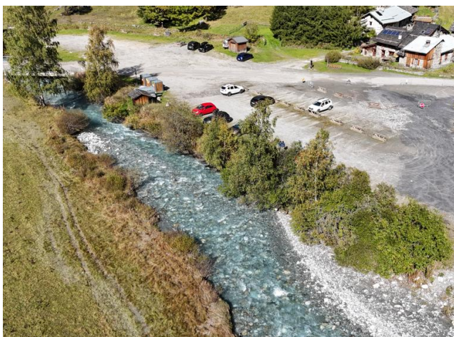
Digue le long du parking en rive droite du Doron
