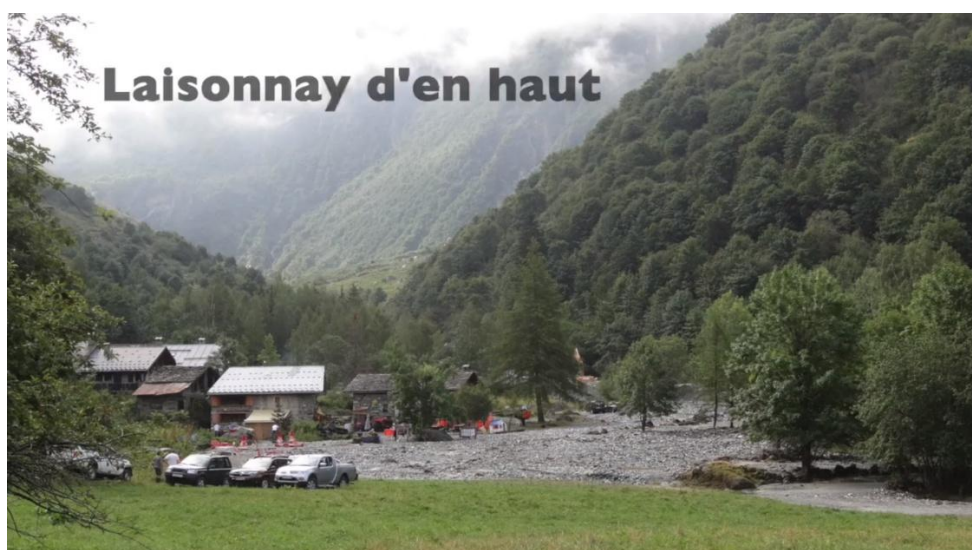
Figure 20 : photos de la crue du 23/07/2015
