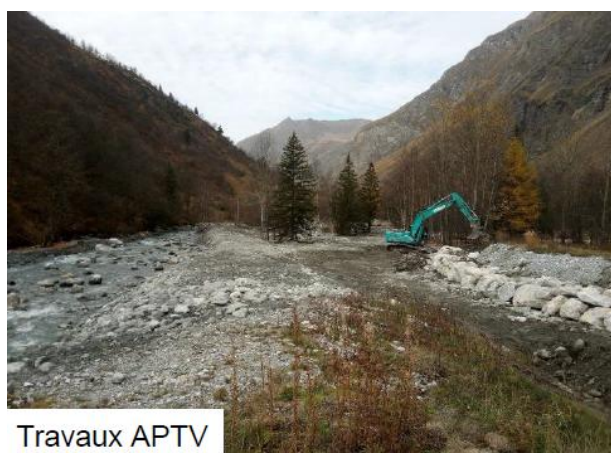
Figure 50 : protection de l'extrémité aval du merlon O4 (source : APTV)
