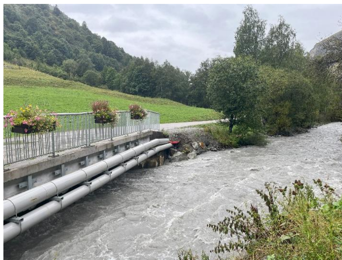
Figure 81 : réseaux coté aval du pont départemental
