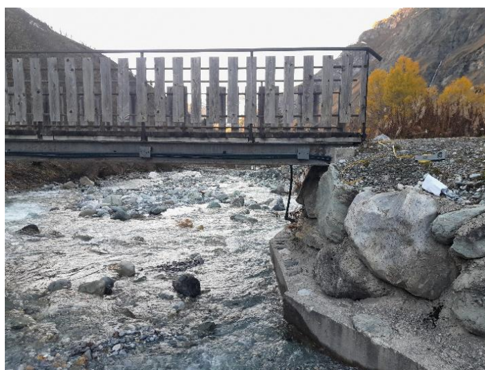
Figure 82 : Conduite d'eau sur la passerelle
