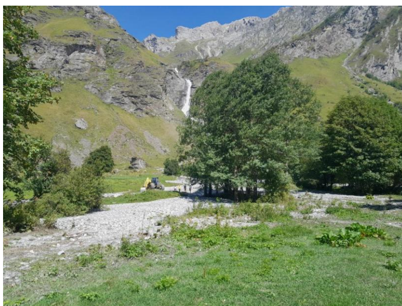
Figure 35 : Derniers dépôts en rive droite du Doron (le 18/08/2025)
