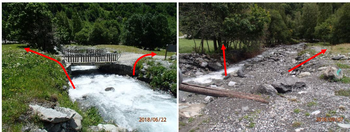
Figure 43 : Pont sur le Py et lit engravé à faible pente à l'aval (débordements possibles en rouge)
