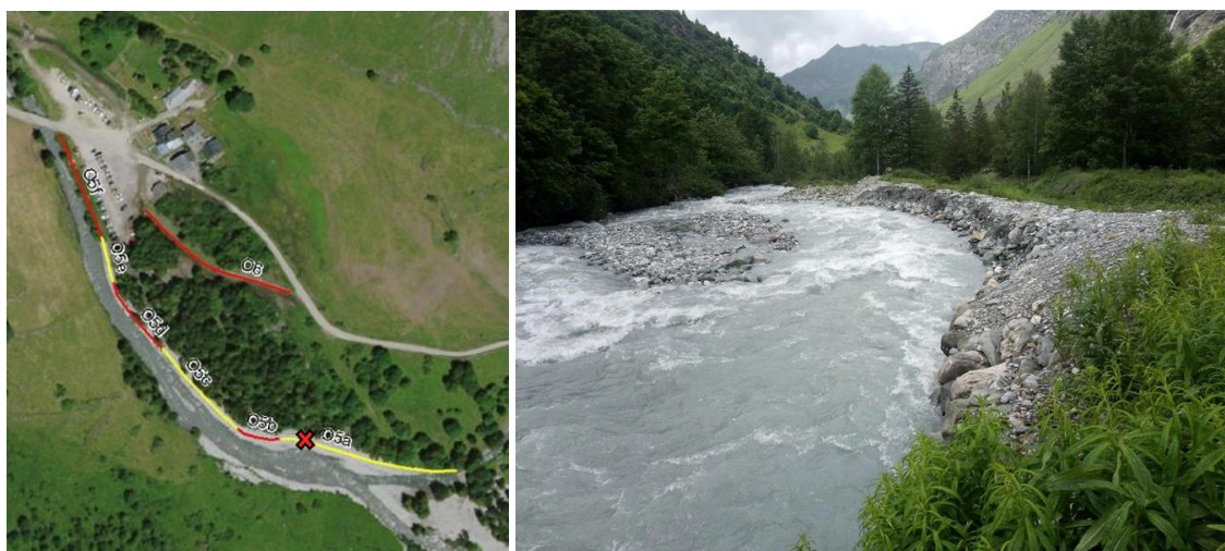
Figure 27 : érosion lors de la crue du 21/06/2024 (source : APTV)
