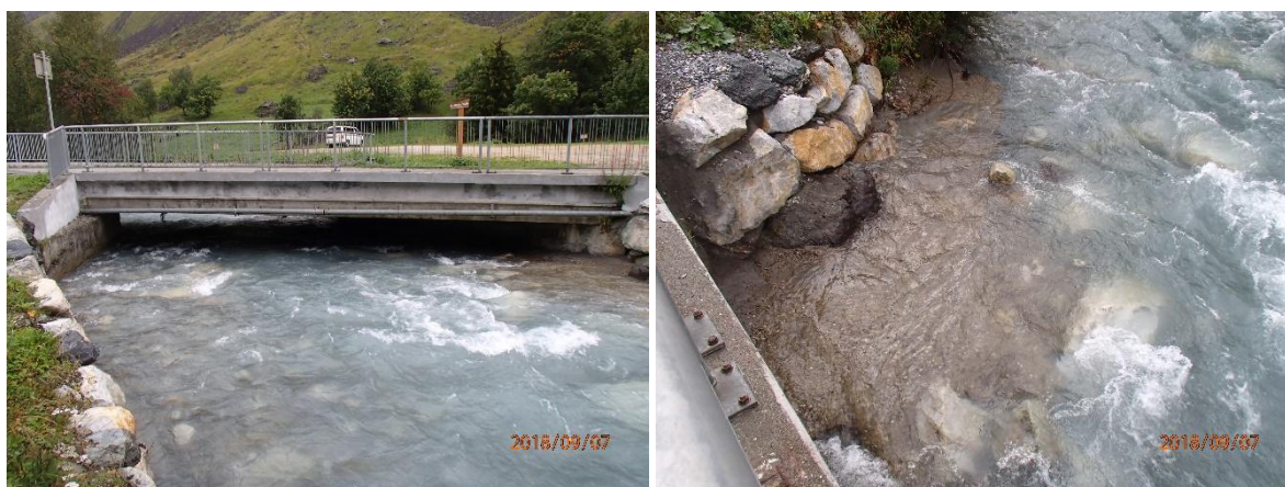
Figure 16 : Pont de la route départementale au Laisonnay d'en Bas
