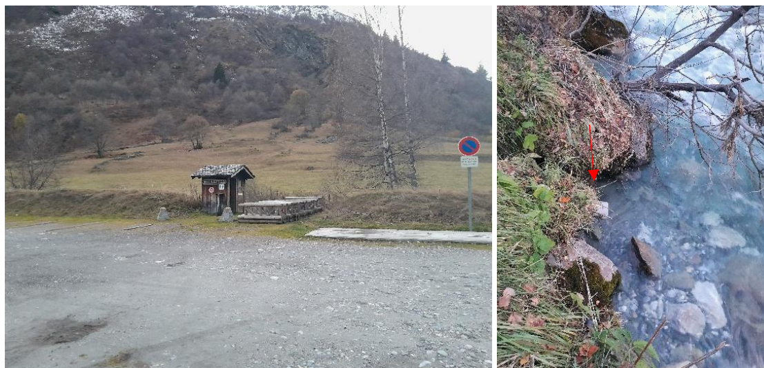
Figure 83 : toilettes publiques et rejet dans le Doron
