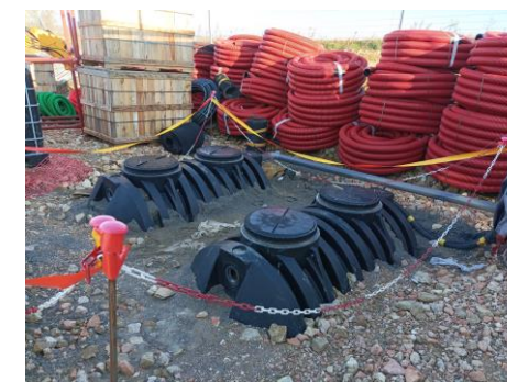
Illustration 3 : Stockage de matériel et cuves d'eau enterrées sur une base vie de chantier (source : INDDIGO sur un chantier de centrale solaire au sol pour VALECO)
