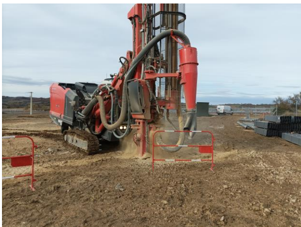
Illustration 1 : Forage et implantation de micropieux d'ancrage, à gauche et fixation des panneaux solaires sur les tables après alignement final, à droite (source : INDDIGO)
