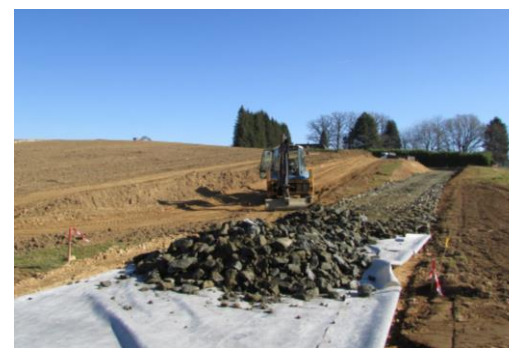
Illustration 2 : Création d'une piste d'accès sur un chantier (source : INDDIGO)
