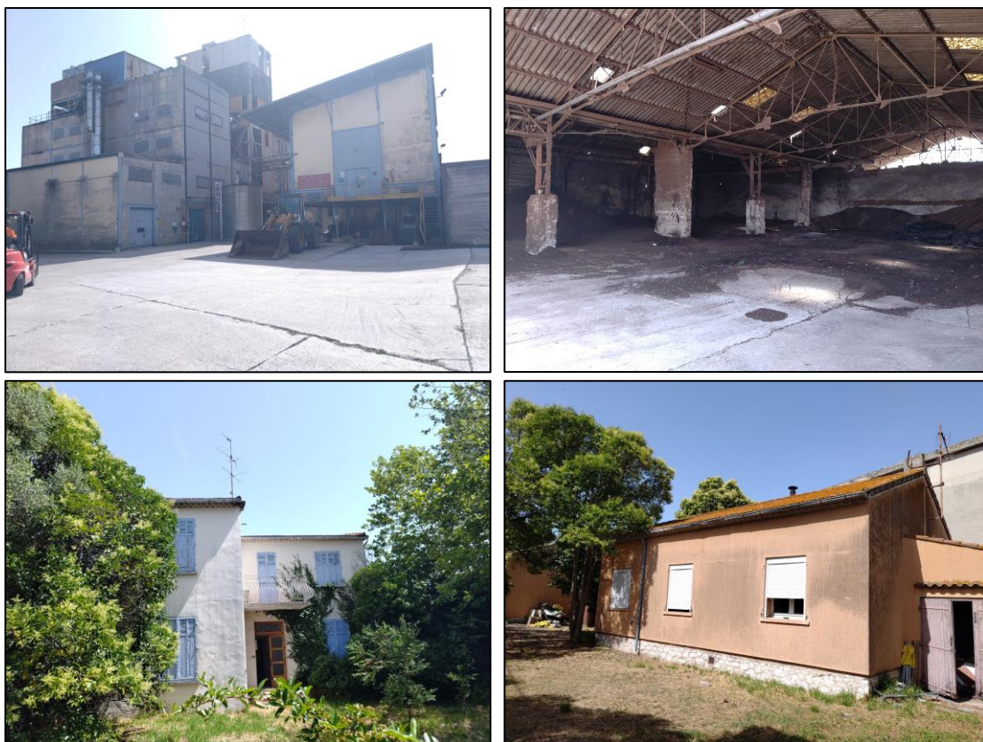
Figure 7 : Hangar industriel (en haut) et bâtis et jardins à l'abandon (en bas) présents sur le site d'étude
