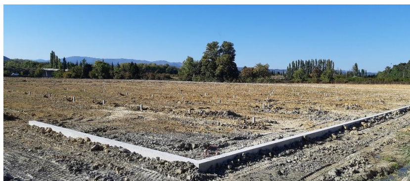
Figure 18 - Fondations béton extérieures (longrine). Reden.
