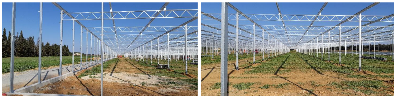
Figure 16 - Montage structure d'une serre photovoltaïque. Reden.
