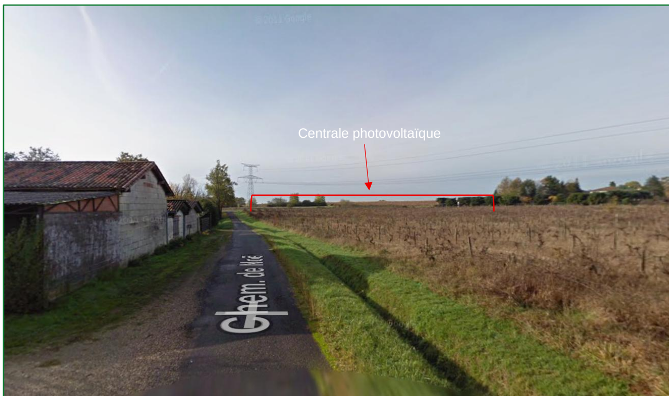
Vue n°2 : vue proche depuis l'habitation la plus proche sur le chemin de Noël (Date photo : novembre 2010, Google Maps).
