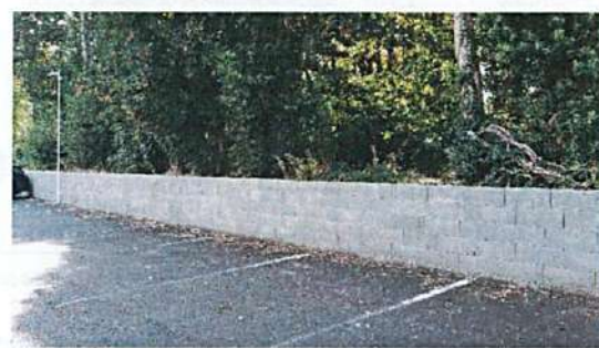
Digue en rive droite à Issoire en aval de la D716
