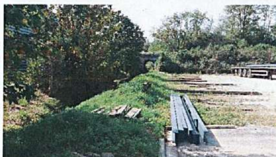
Digue en rive gauche à Issoire en aval de la voie ferrée
