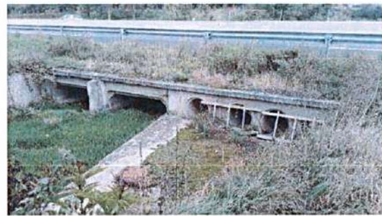
Ouvrage n°34 à Issoire – Cadres et buses sous l'A75
