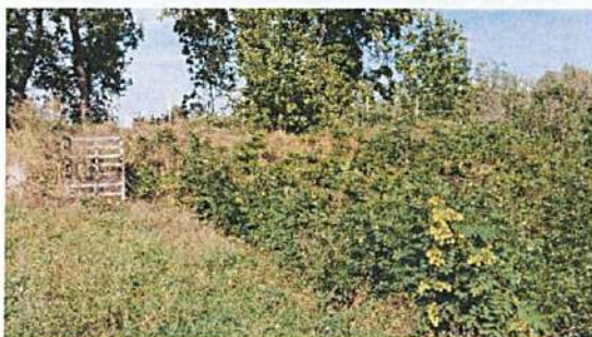
Digue en rive droite à Issoire en amont de l'A75
