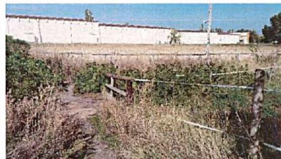
Ouvrage n°36 à Issoire – Passerelle d'accès au centre équestre
