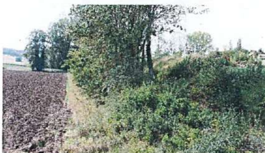
Digue en rive gauche à Issoire en amont de la D716
