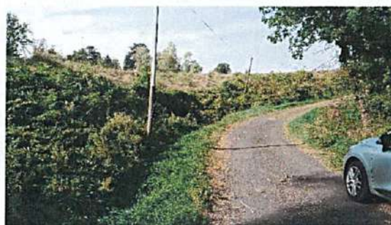
Barrage du 3 ème étang à Bergonne au domaine de Malbattu
