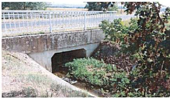
Ouvrage n°32 à Issoire – Cadre sous route
