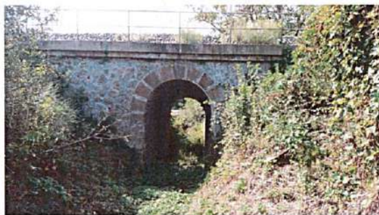
Ouvrage n°33 à Issoire – Pont arche sous la voie ferrée
