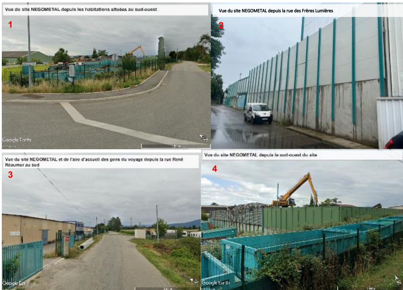
FIGURE 4 : VUE AERIENNE LOCALISANT LES HABITATIONS LES PLUS PROCHES DU SITE ET PRISES DE VUE DU SITE DEPUIS L'EXTERIEUR
