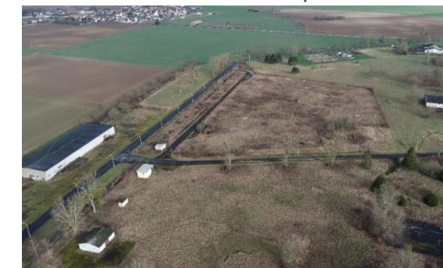
Vue sur l'ancien dépôt pétrolier depuis le sud
