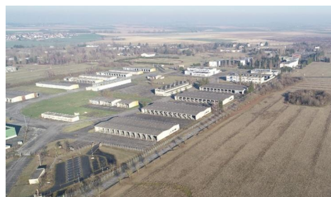
Vue sur les hangars de la zone technique depuis le sud
