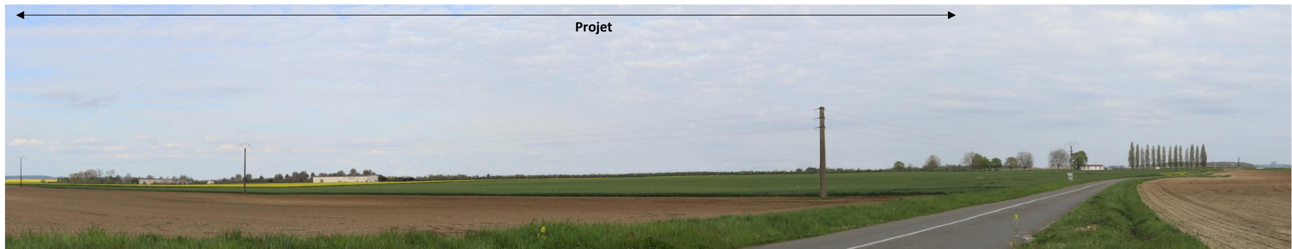
Figure 26 : Photomontage n°14 – Vue depuis l'intersection de la D54 et de la D26 au sud-ouest du projet – Etat projeté avec mesures et sans bâtiments militaires (©ATER Environnement, 2025)
