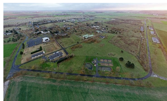
Vue sur la zone vie depuis le nord-ouest
