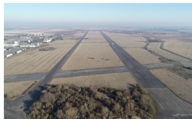
Vue sur la piste aérienne et taxiway depuis le sud
