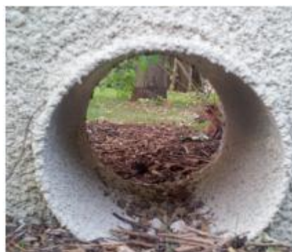
Aménagement d'ouverture de muret - © U2B
