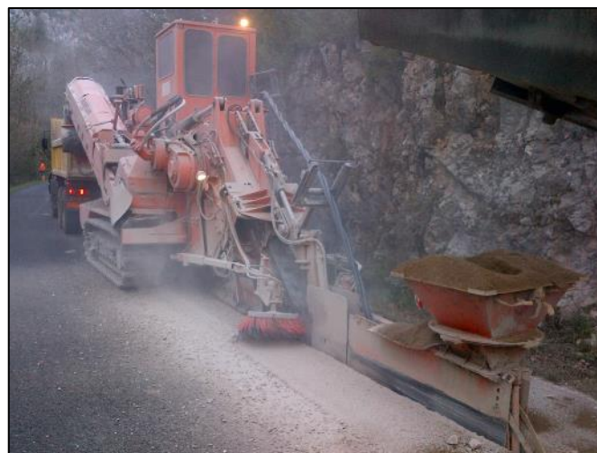
Figure 17 : Photo de trancheuse prise sur chantier (Source : wpd)
