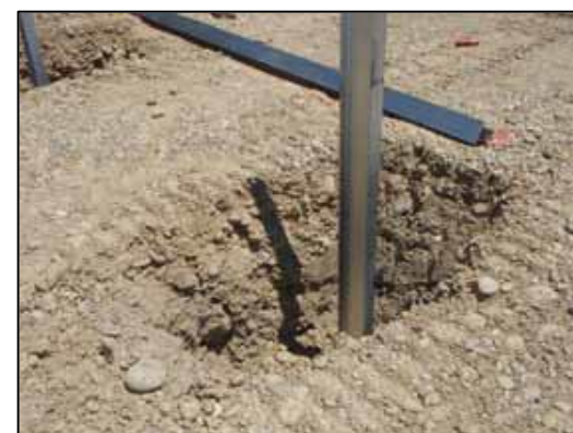
Figure 11 : Types de fondation - pieux battus
