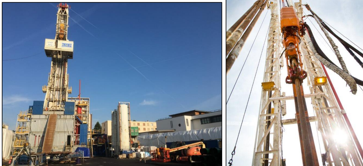
Figure 10 – Exemples d’ateliers de forages géothermiques
