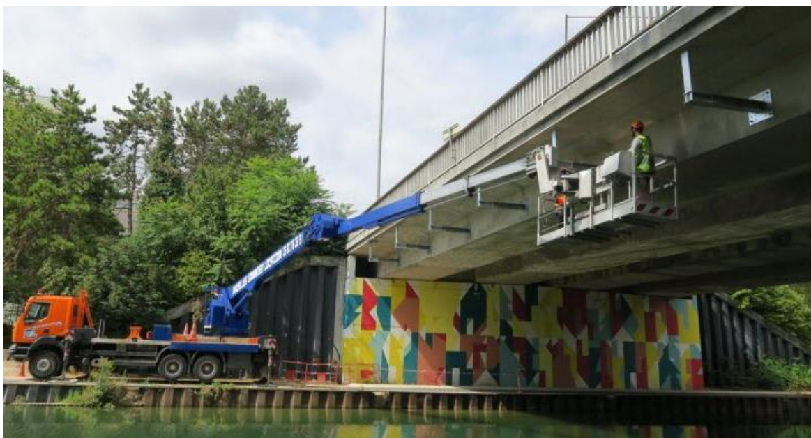
Figure 10 : Franchissement par encorbellement
