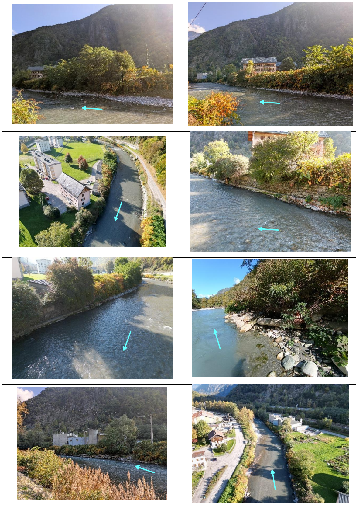
Figure 7: Photographies de la digue rive droite - La Coulée, 2025
