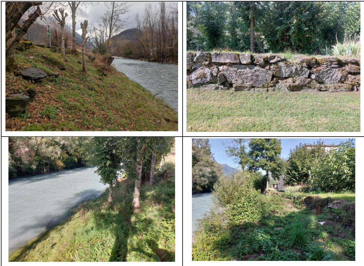
Figure 4: Photographies du tronçon aval de la digue du plan du Truy
