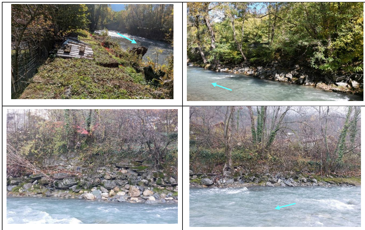
Figure 3: Photographies du tronçon 2 de la digue du plan du Truy
