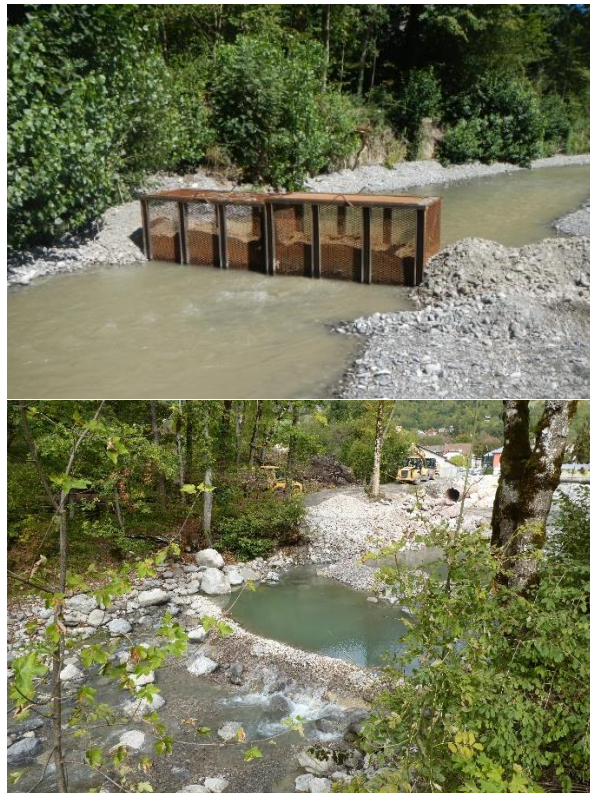
Figure 61 : Exemple d'un barrage filtrant « paille » (HYDRETTUDES, Saint Ruph 74, 2015) et par gravelette (HYDRETTUDES, Foron de Taninges 74, 2018)
