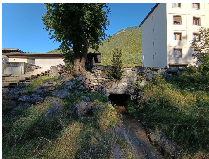
Figure 67: Vue sur la sortie du réseau EP observée
