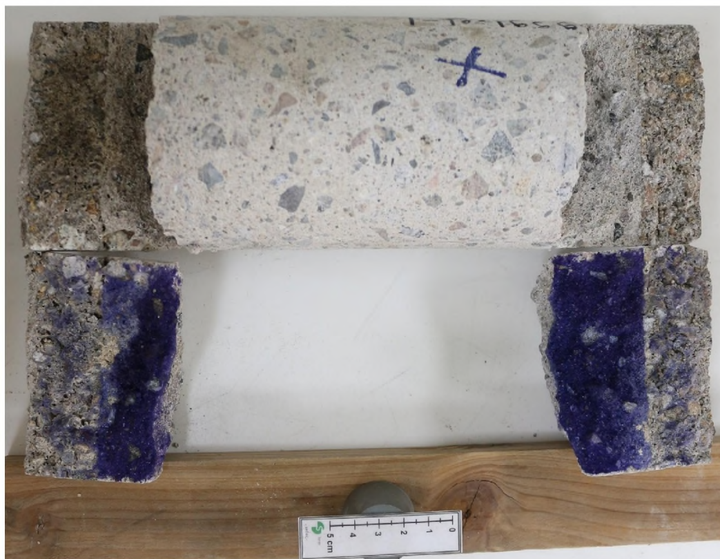
Illustration du front de carbonatation (surface testée à droite)
