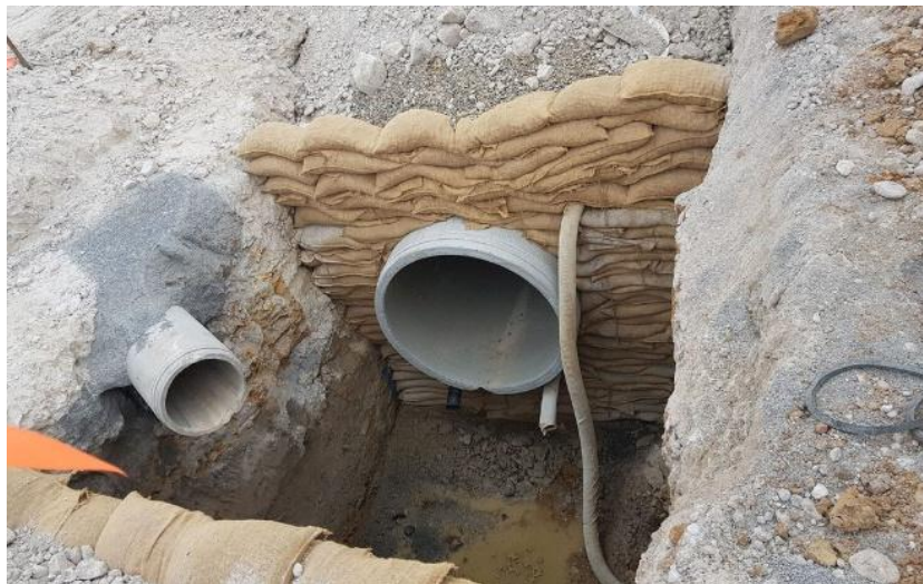
Figure 9 : Exemple de pose de canalisation provisoire avec stabilisation type big-bags
