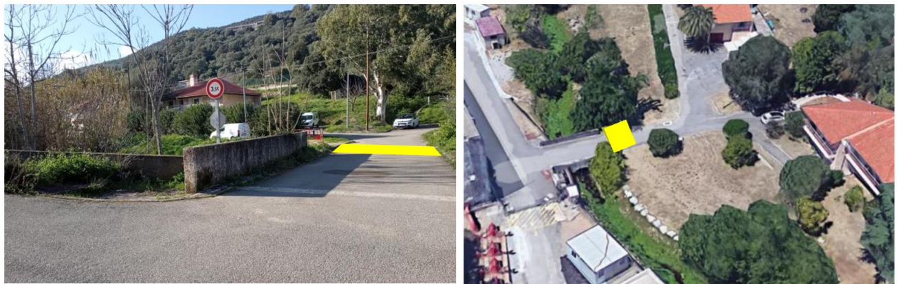
Figure 2 : Localisation du dos d'âne sur le site d'ENGIE Loretto
