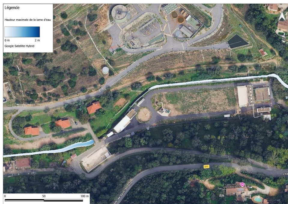
Figure 25 Lame d'eau maximale en cas de débit biennal estival lors de la phase chantier protégé par un tuyau de dérivation Ø400 mm
