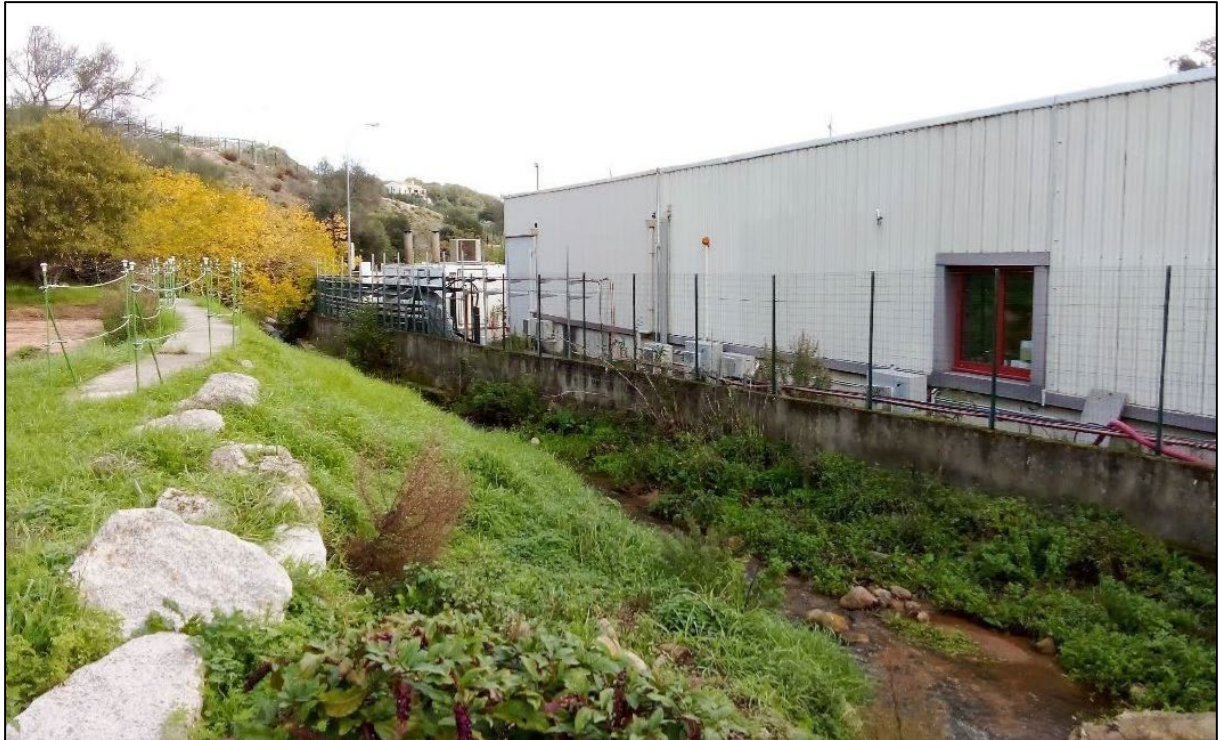
Photo 1. Mur de soutènement qui sera reconstruit (source : ENGIE)
