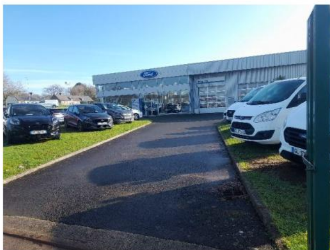
Photo N°3: Vue sur l'entrée du site Ouest
