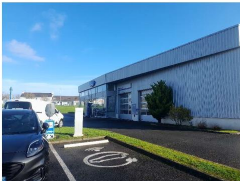
Photo N°2: Vue sur le site depuis le Sud-Ouest
