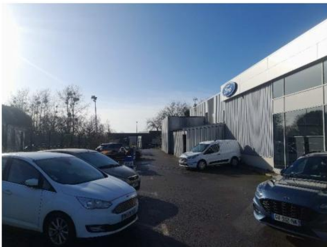
Photo N°7: Vue sur les stationnements et zones de stockage Est
