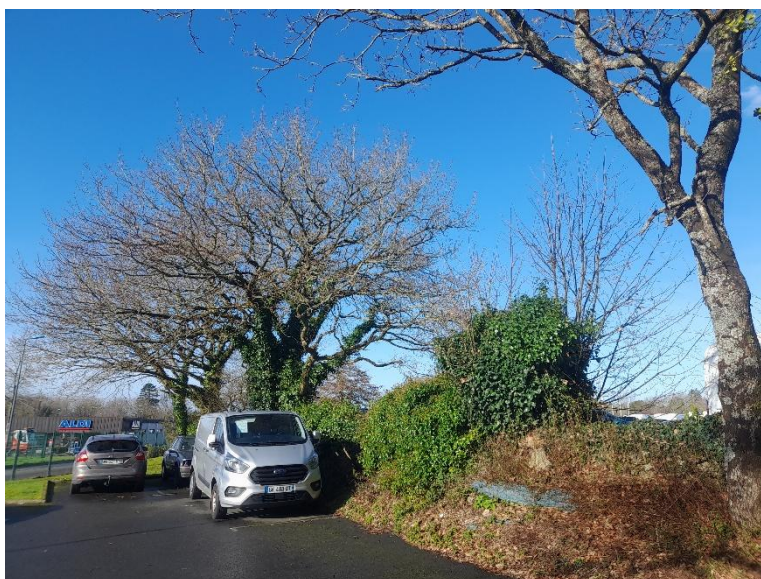
Haie Sud discontinue
