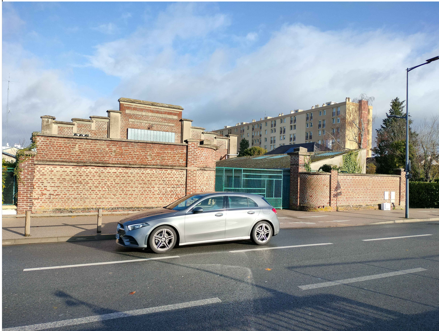
1/ Entrée depuis la rue Alexandre Dumas vers le bâtiment existant
