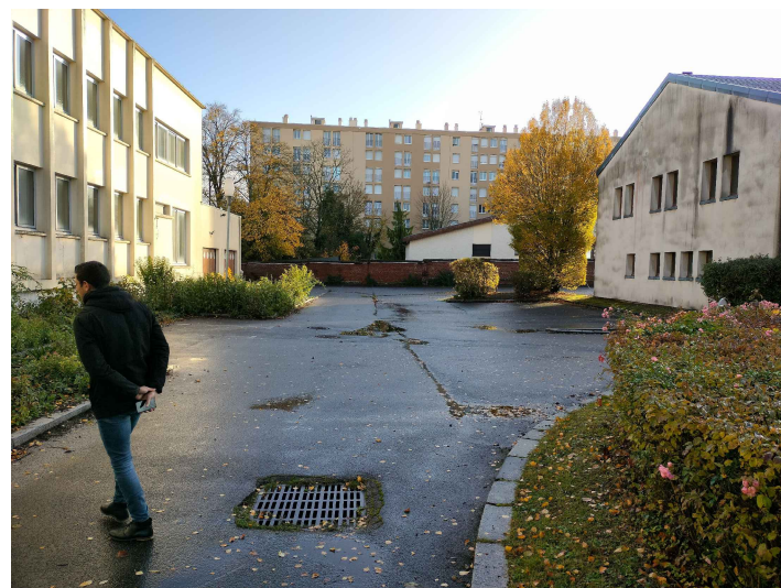
4/ Fond de parcelle et bâtiments voisins
