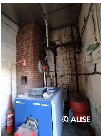
Photo 34 : Vue de l'annexe (photo sur site)
