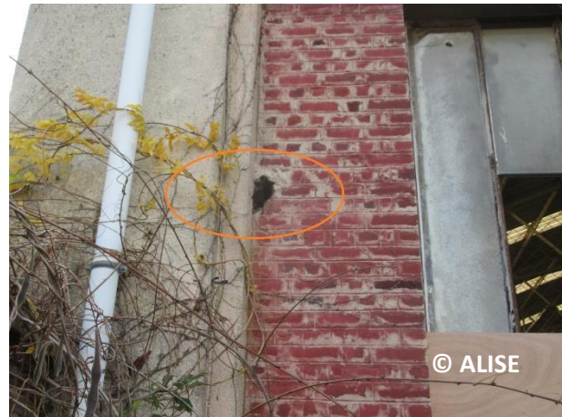
Photo 37 : Cavité favorable dans un mur en briques (photos sur site)
