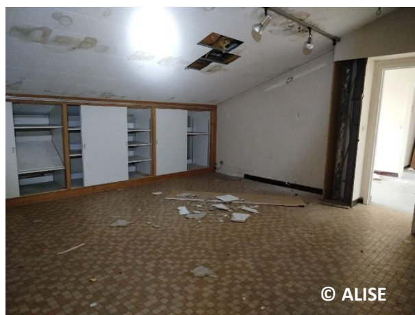
Photo 10 : 1er étage de la partie laboratoire (photo sur site)
