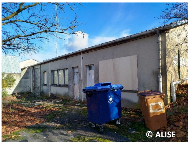
Photo 15 : Bureaux, façade Ouest
