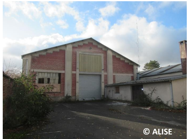
Photo 5 : Façade Sud. Hangar automobile (photo sur site)
