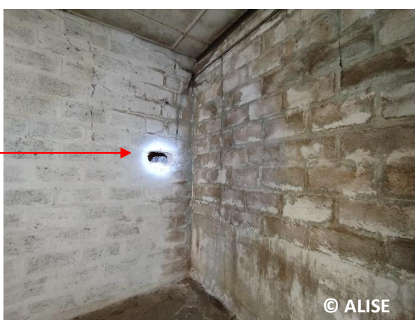
Photo 22 : Accès par mur mitoyen entre portion favorable.
