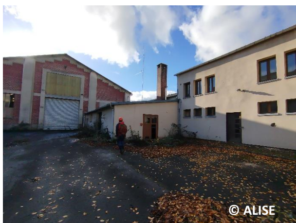
Photo 2 : Façade Nord. De gauche à droite, court de tennis – annexe technique avec cheminée – laboratoires (photo sur site)
