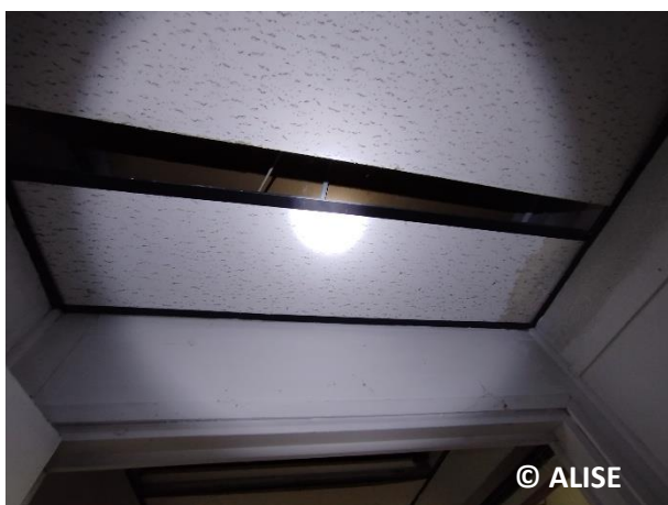
Photo 9 : Rez-de-chaussée de la partie laboratoire (photo sur site)
