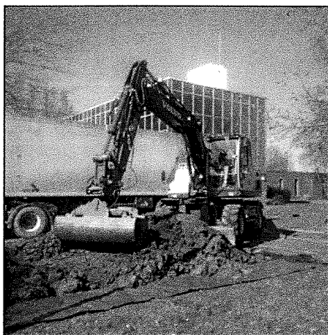
Figure 16 : Chargement et évacuation des terres polluées
