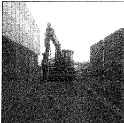
Figure 7 : Dépose des enrobés
