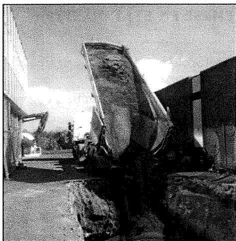
Figure 18 : Livraison de la terre chaulée et compactage au « pied de mouton »
