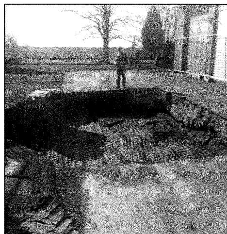
Figure 18 : Livraison de la terre chaulée et compactage au « pied de mouton »
