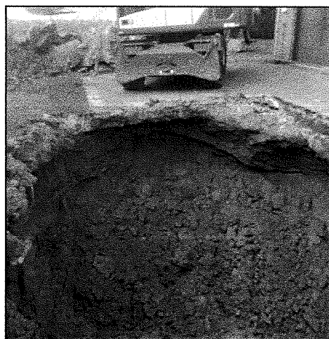
Paroi Ouest (K6)
