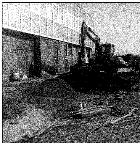
Figure 19 : Mise en œuvre de graves béton et compactage
