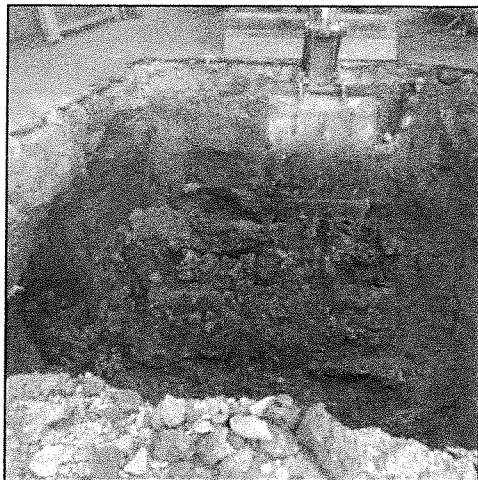
Figure 11 : Terrassement des matériaux pollués (coloration bleuâtre)
