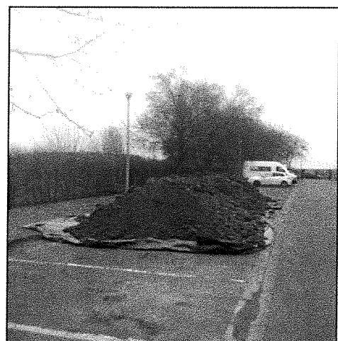
Figure 12 : Stockage des matériaux pollués sur une aire étanche
