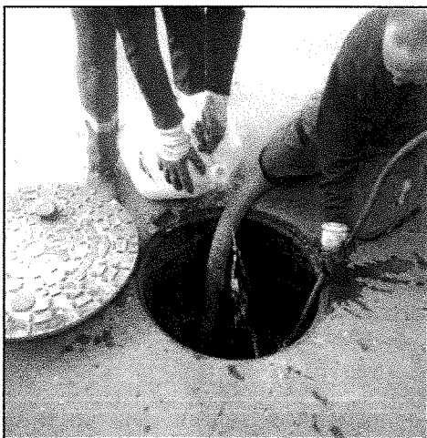
Figure 5 : Nettoyage au produit dégraissant
