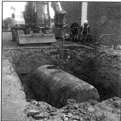
Figure 9 : Extraction de la cuve de 10 m 3 et inspection visuelle
