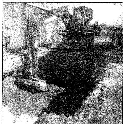
Figure 17 : Remise en fouille des remblais de surface
