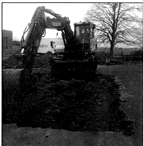
Figure 8 : Dégagement et stockage des remblais de surface
