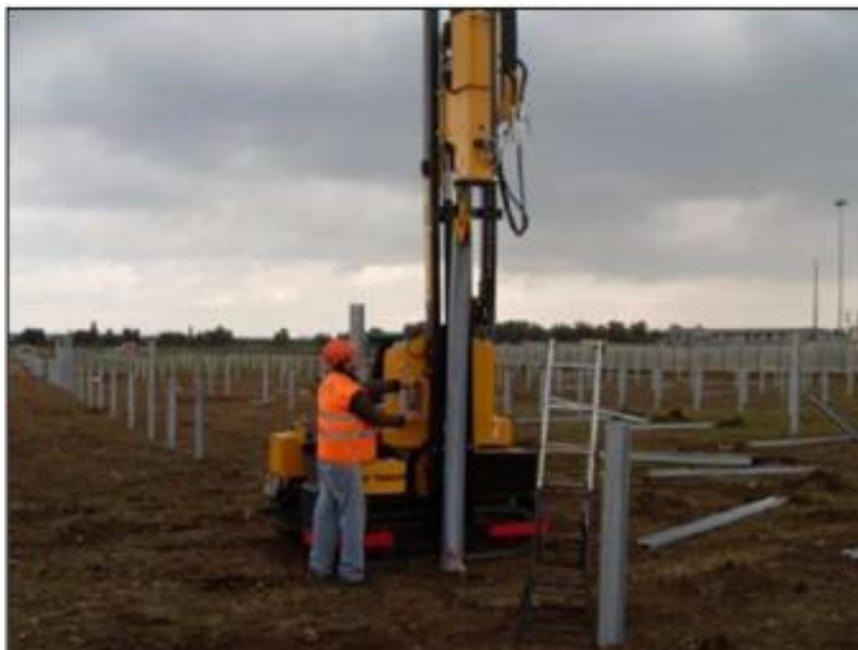
Exemple d'installation des pieux battus
