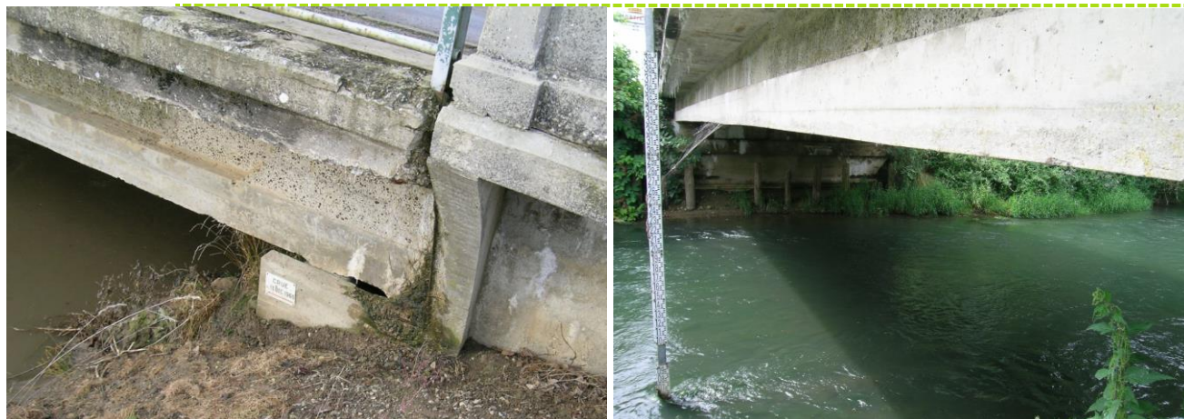
Figure 8 : Repère de crue du 13/12/1966 à gauche et du 06/01/2001 à droite.
