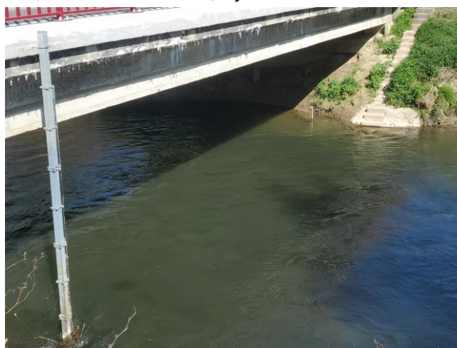
Figure 9 : Station de Mortiers au 07/04/2025.
