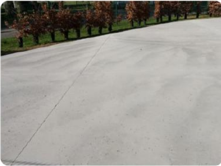
Béton taloché : emplacements caravanes
