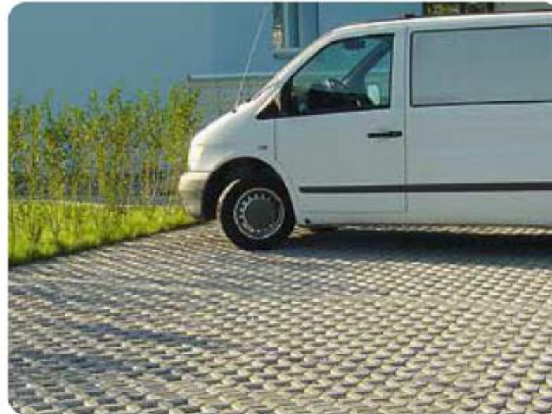
Stationnements véhicules sur les emplacements en dalles drainantes, enherbées ou engravillonnées
