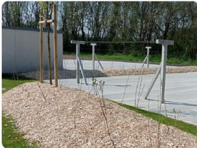
Fil à linge - Poteaux béton
