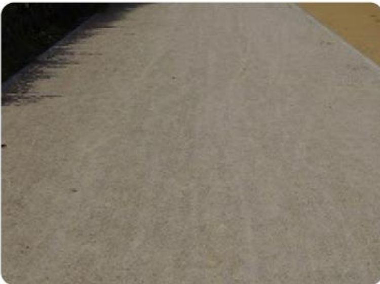
Stabilisé clair : circulations piétonnes, zone de convivialité
