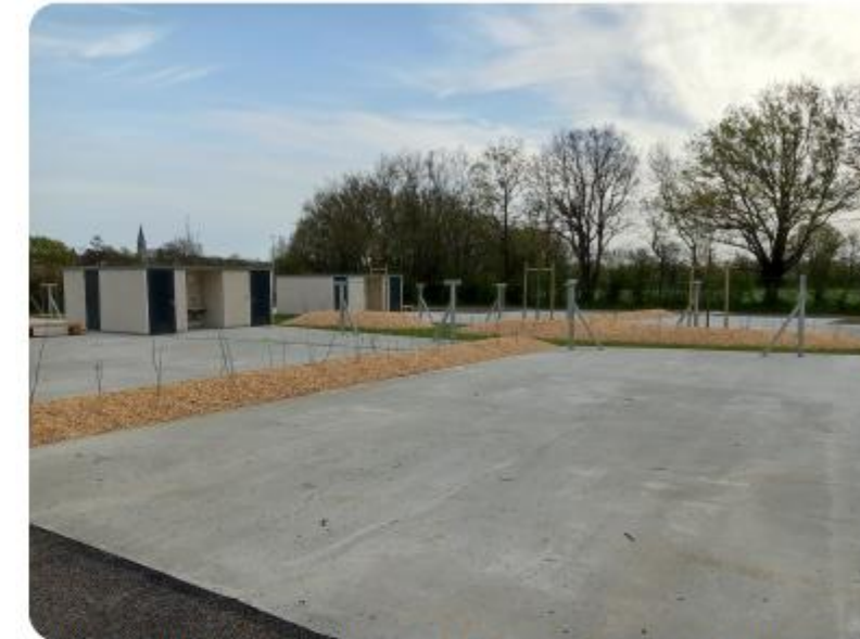
Plantations entre les emplacements caravanes
