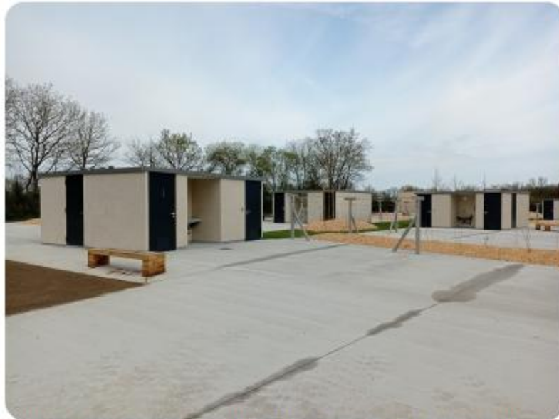
Revêtement des emplacements en béton taloché
