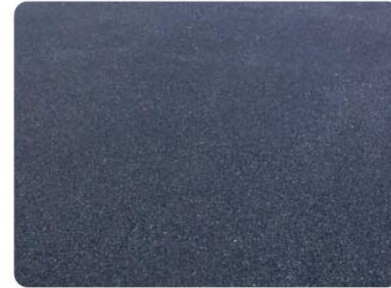
Enrobé noir : voirie
