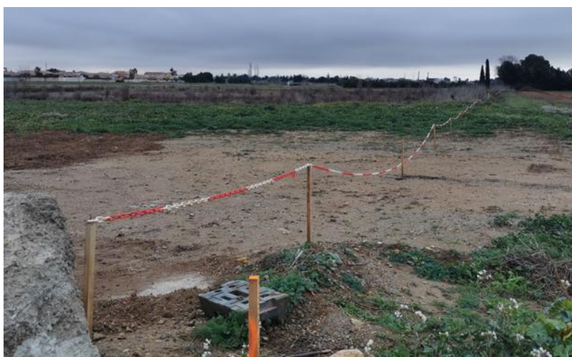
Exemple de balisage utilisé lors d'une mise en défens (Altemis)
