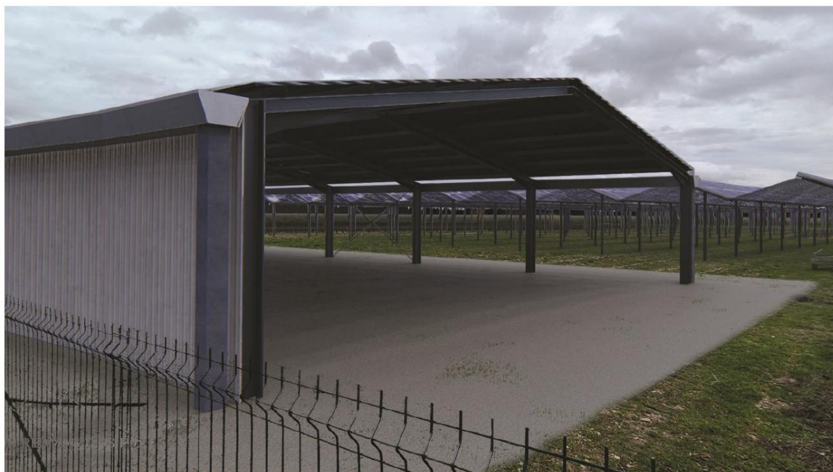
Figure 3 : Vue après travaux
