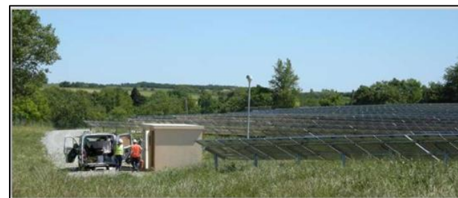
Figure 46 : Opération de maintenance
