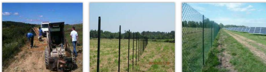
Figure 36 : Mise en place de la clôture (pose des ancrages, des piquets et du maillage)
