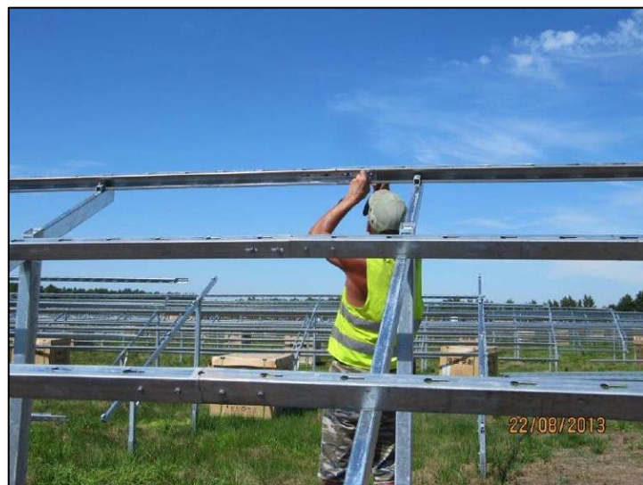
Figure 29 : Systèmes de fixation pour installation photovoltaïque
