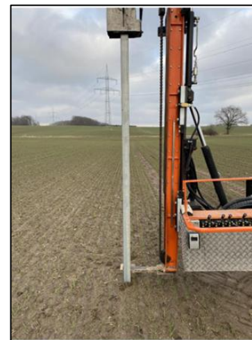
Figure 32 : Battage des pieux
