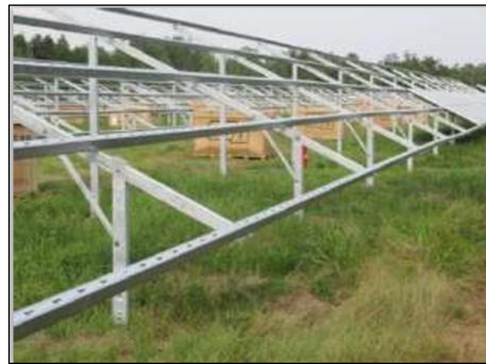
Figure 30 : Système sur pieux
