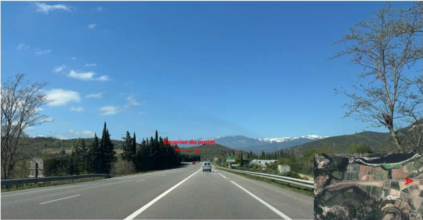
Photographie depuis la RD 66 en direction de Marquixanes
