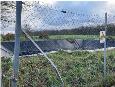
Figure 8 : Clôture grillagée existante
