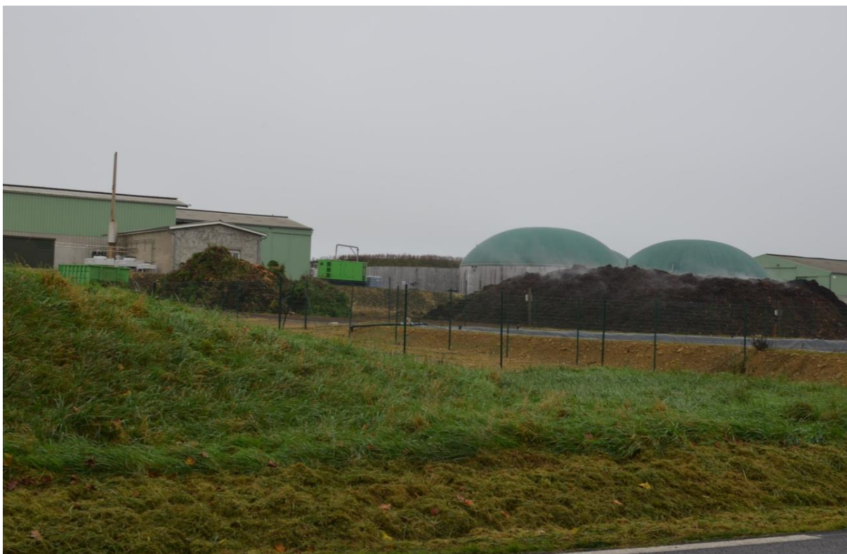
Méthaniseur – Source : KDE ENERGY France
