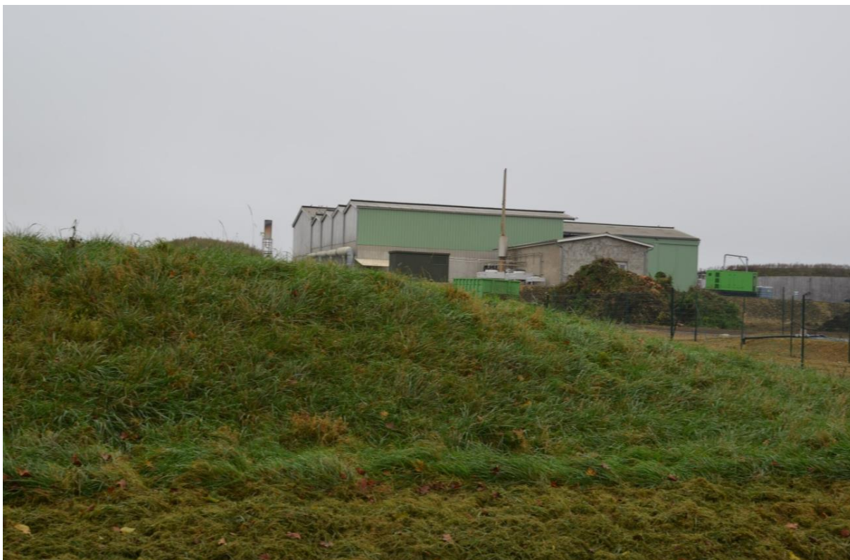
Méthaniseur – Source : KDE ENERGY France
