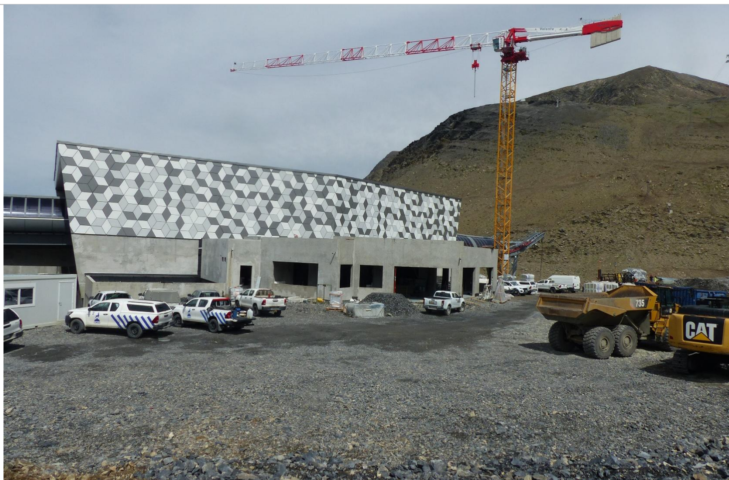
Zone de travaux
