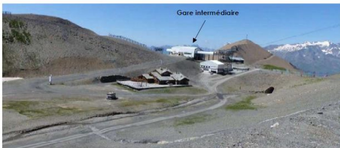
Photo sur l'ancienne gare intermédiaire du Jandri Express depuis la piste d'accès au glacier Point d'observation VL2 (VL pour « vue locale depuis des points de vue fréquentés »)
