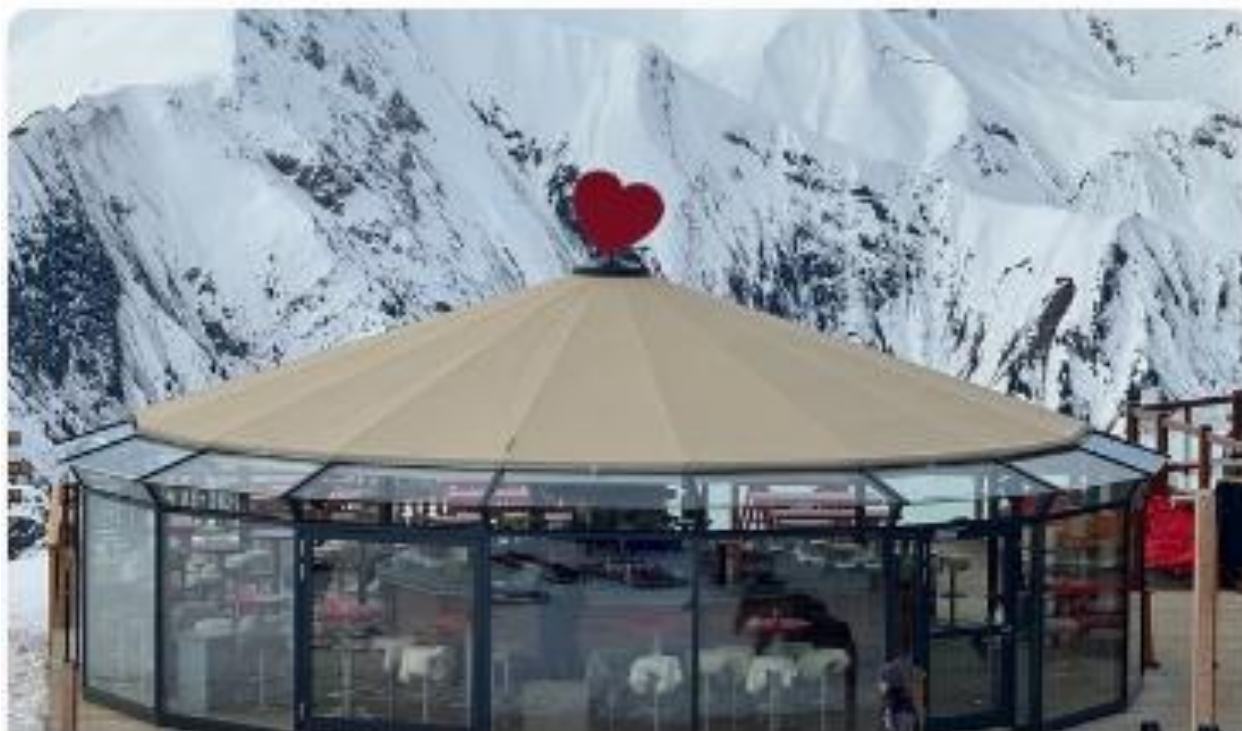
Exemple de terrasse vitrée couverte - Source : https://www.stores-sudest.com/realisations
