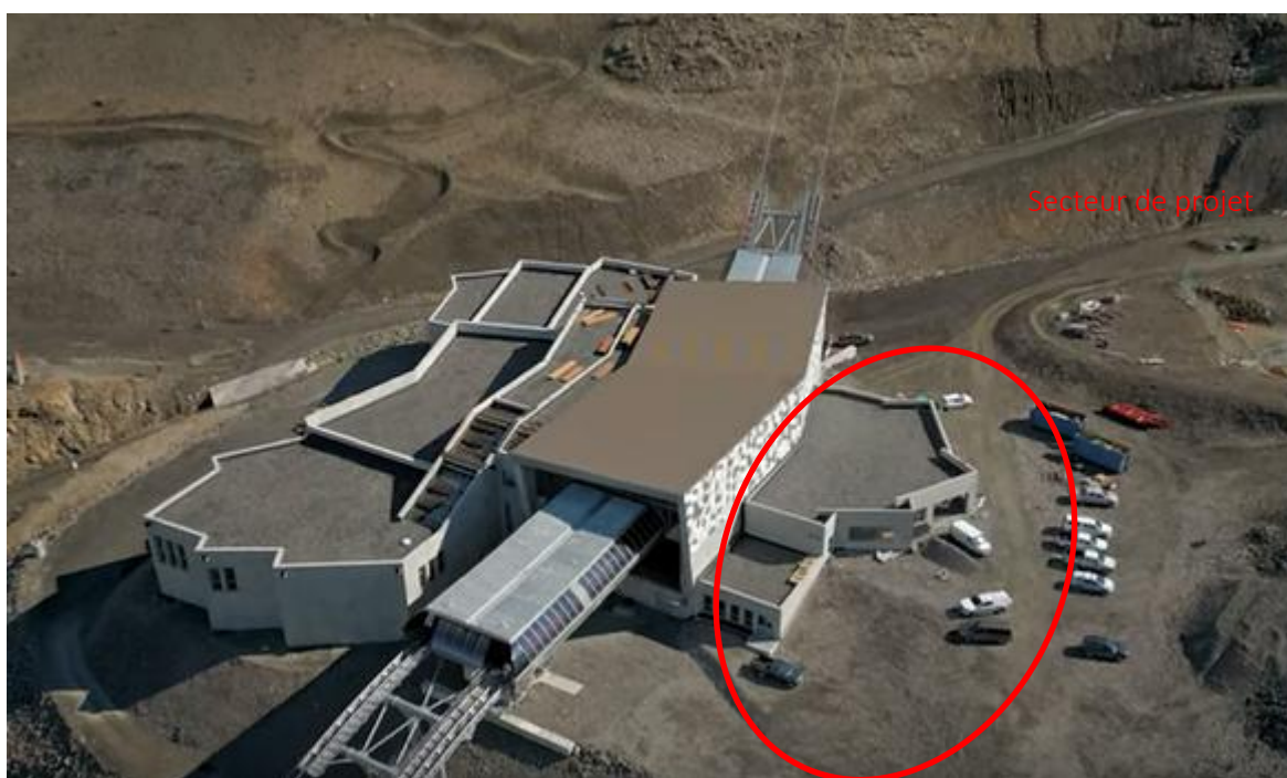
Photographies de la nouvelle gare intermédiaire du Jandri 3S – Source : youtube.com (Les2neigeaux)
