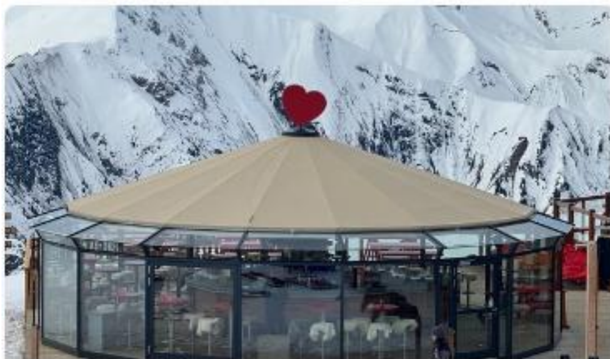
Exemple de terrasse vitrée couverte - Source : https://www.stores-sudest.com/realisations
