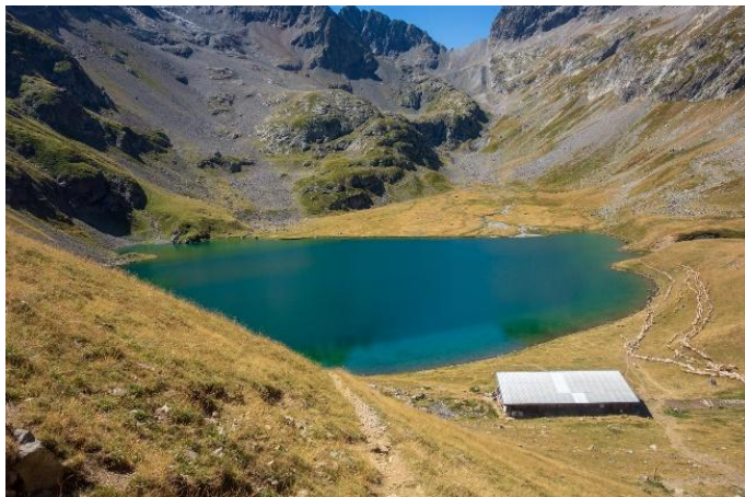
Le refuge existant et son lac - vue depuis le GR54C au nord
