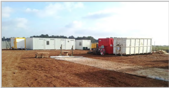
Photographie 1 : Installation de la base vie
