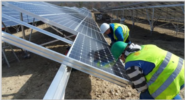
Photographie 10 : Montage des modules
