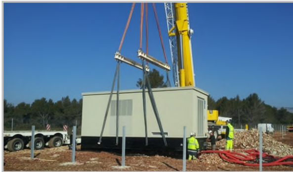
Photographie 12 : Installation des postes de transformation
