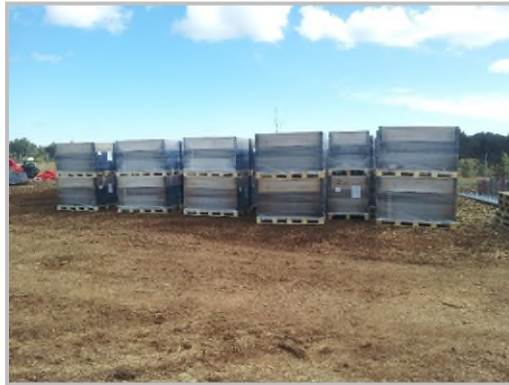
Photographie 7 : Stockage des modules
