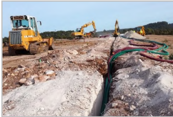
Photographie 6 : Réalisation des tranchées et installation des câbles
