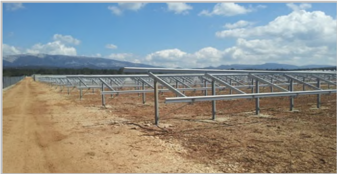
Photographie 9 : Montage des structures
