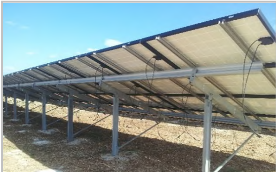
Photographie 11 : Raccordement électrique des modules
